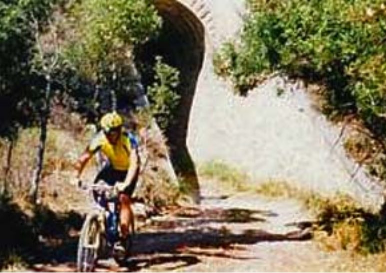
Foto 4. Ponte della ferrovia
